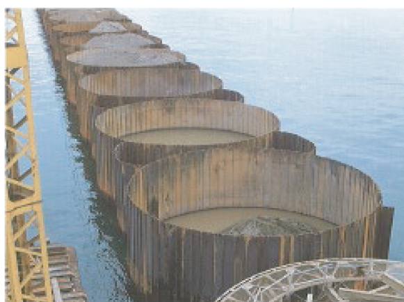
図 2 鋼矢板セル工法
